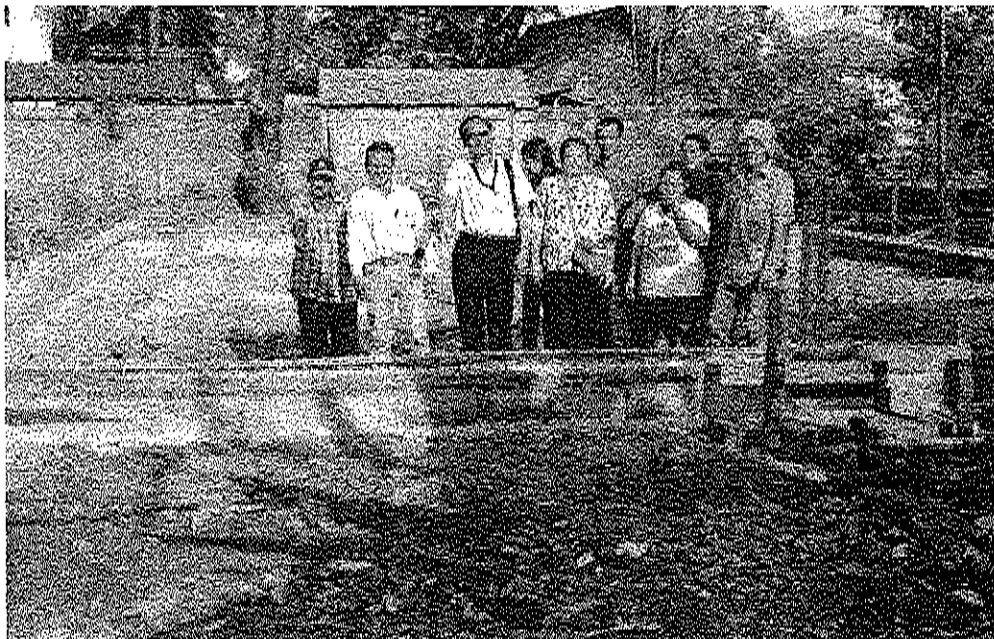
ภาพถ่ายสถานที่ก่อสร้างอาคารศูนย์การเรียนรู้และฝึกอาชีพคนพิการ
